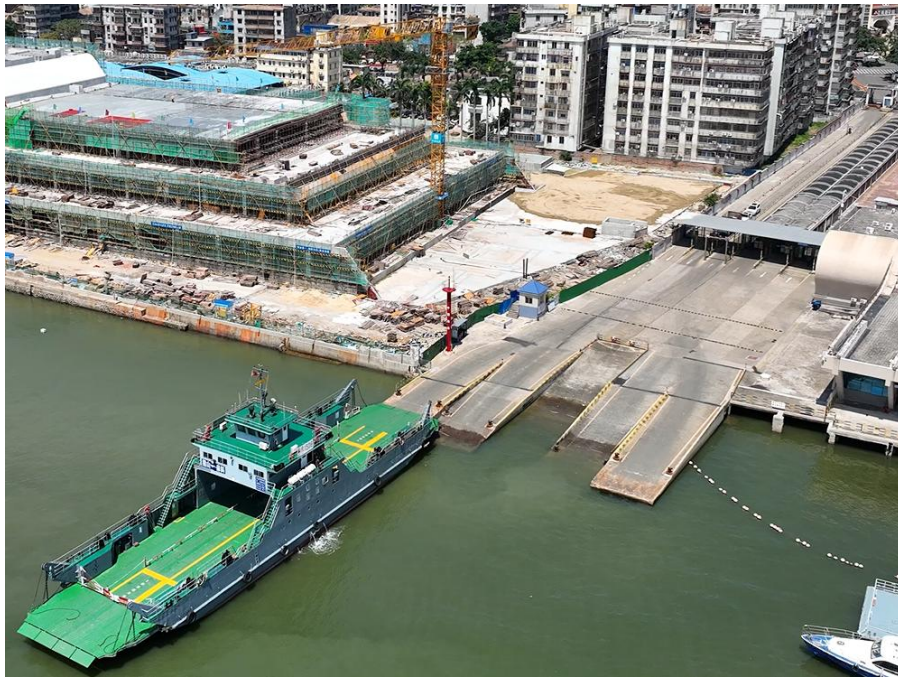
图 4.1.2-2 港池码头用海照片
