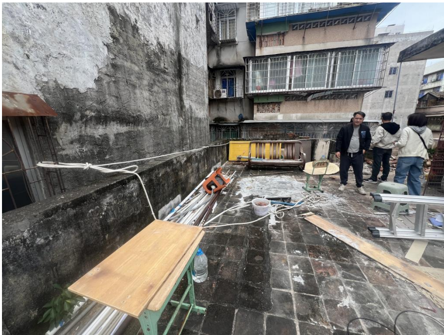
图 7 现场高空作业绳索固定情况
