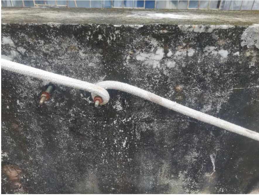
图 8 现场高空作业绳索固定情况
