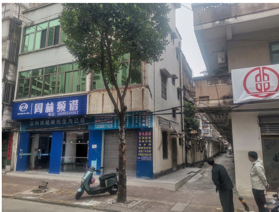
图 1 霞山区友谊二横路 51 号居民楼
