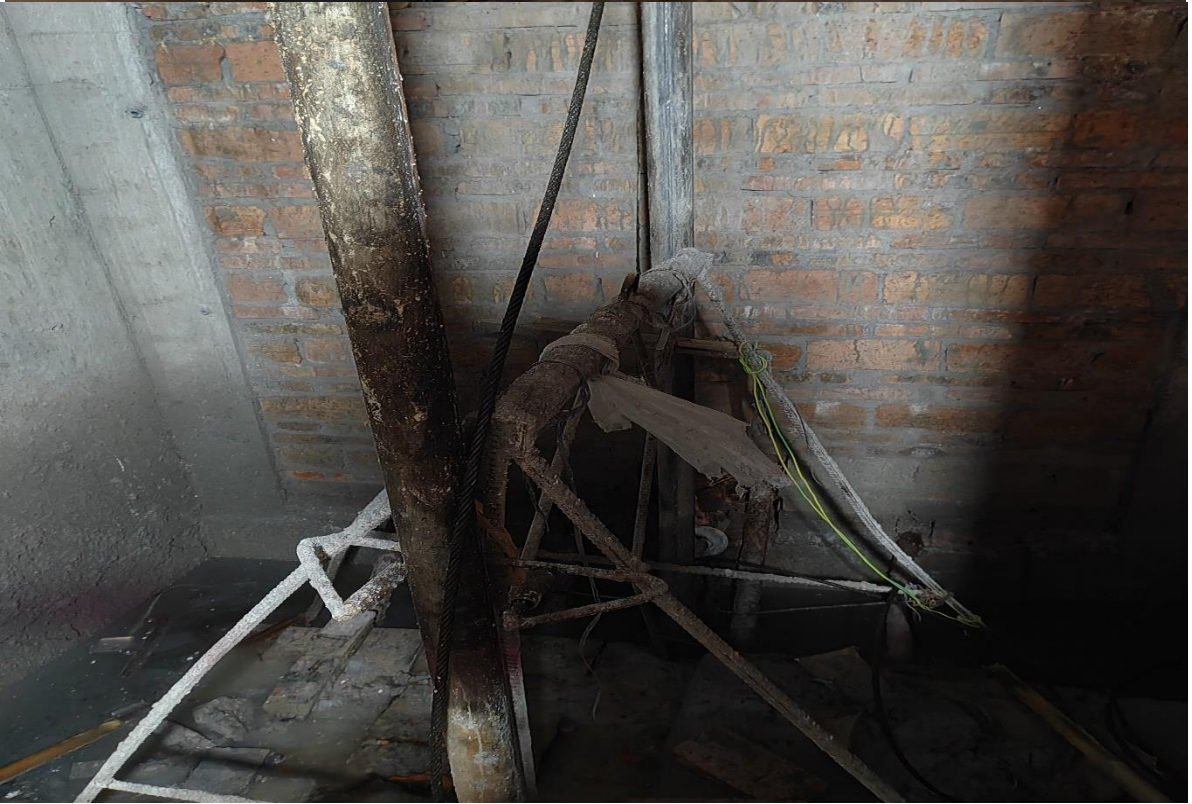
图 1 一楼室内电梯井
