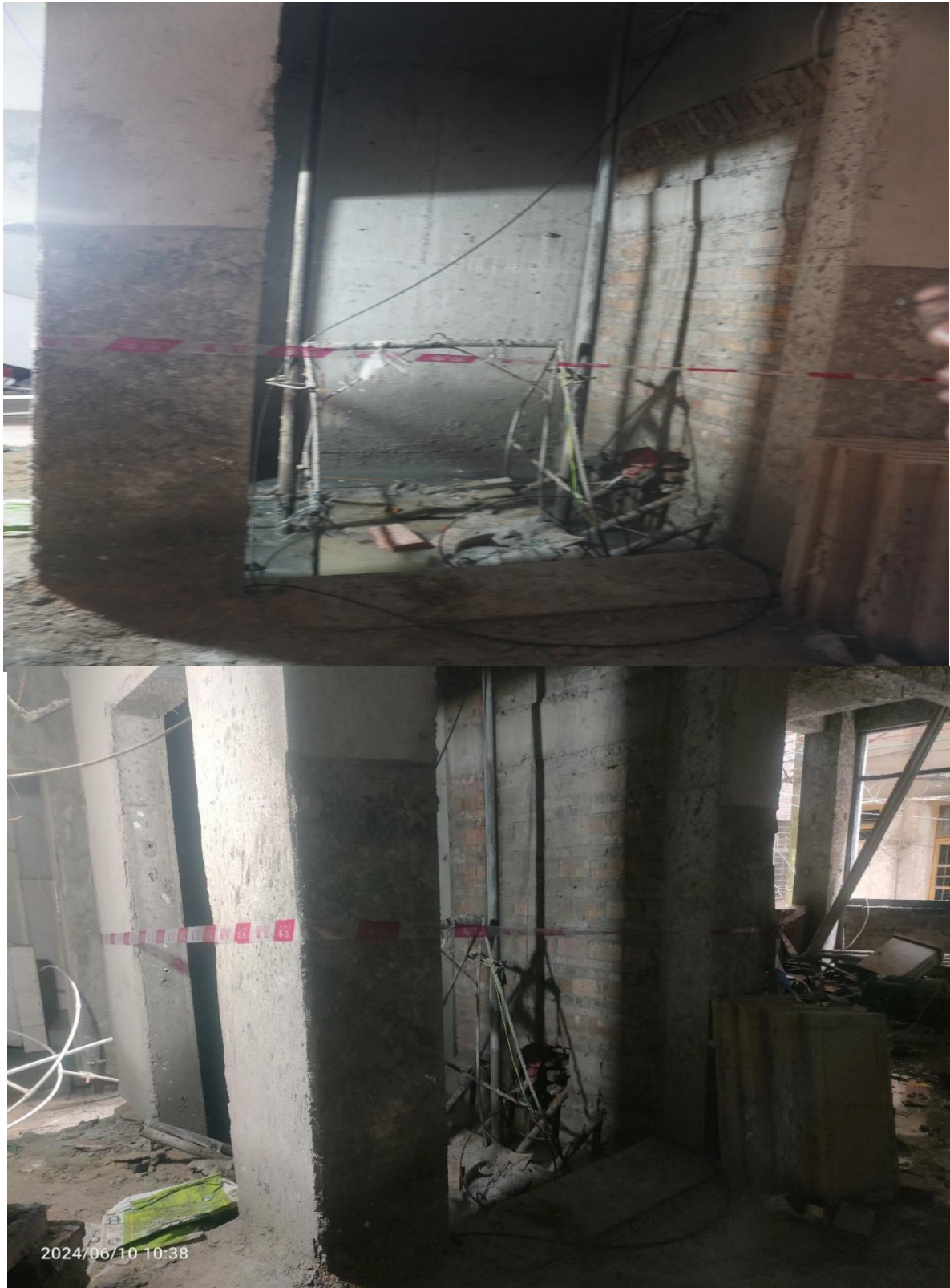
图 2 一楼室内电梯井
