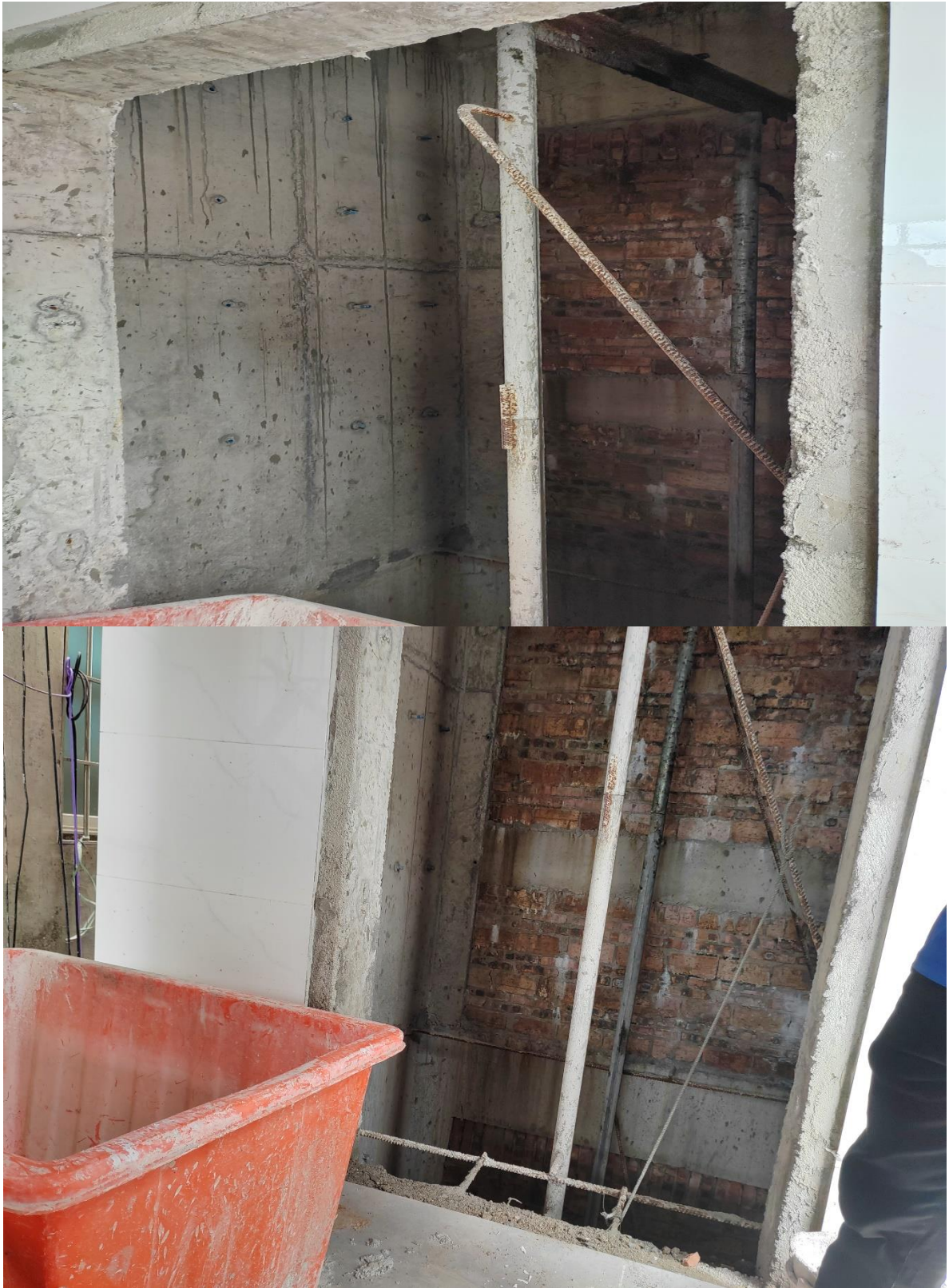
图 3 六楼顶提料施工作业处
