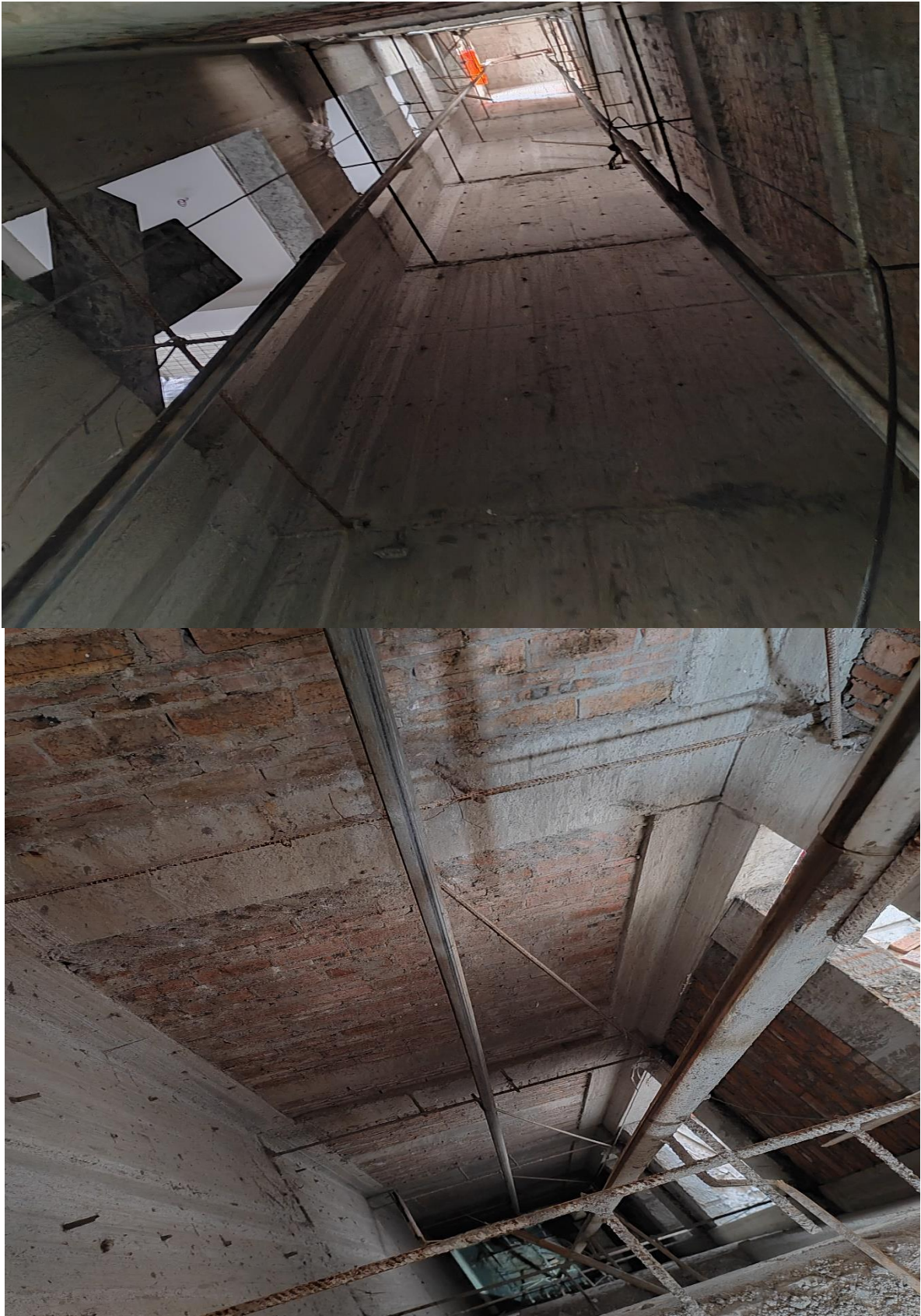
图 4 电梯井内部情况
